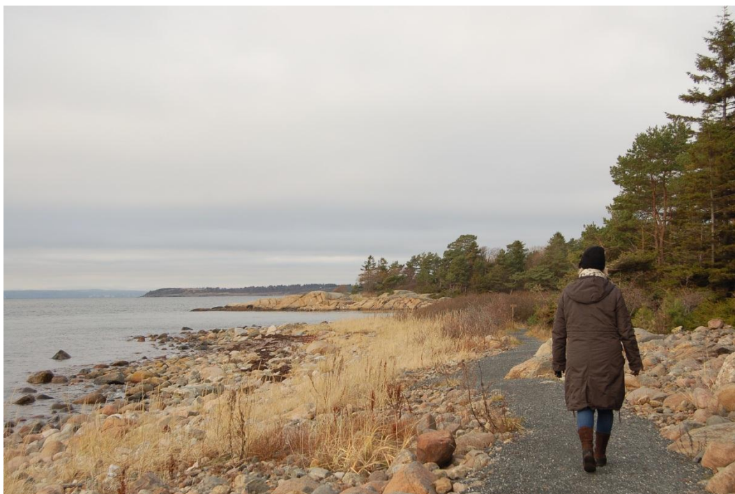
Helt uti vannkanten har arbeidsgjengen i Rygge anlagt bred, slak sti med fast dekke. På odden i det gjerne blir det anlagt en fiskebrygge som er tilpasset rullestolbrukere.
